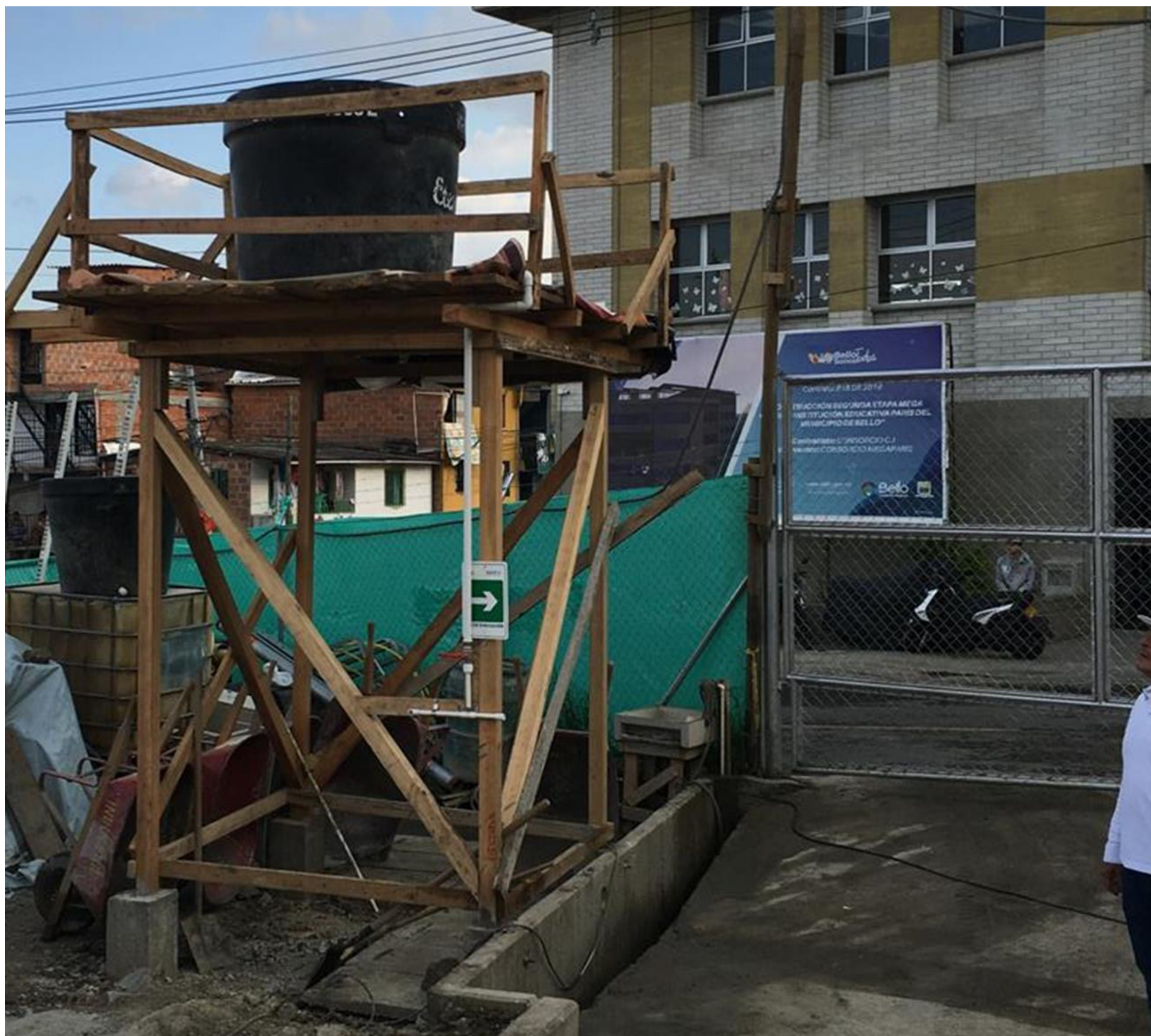
Construcción sistema de circulación de agua para lavallantas
