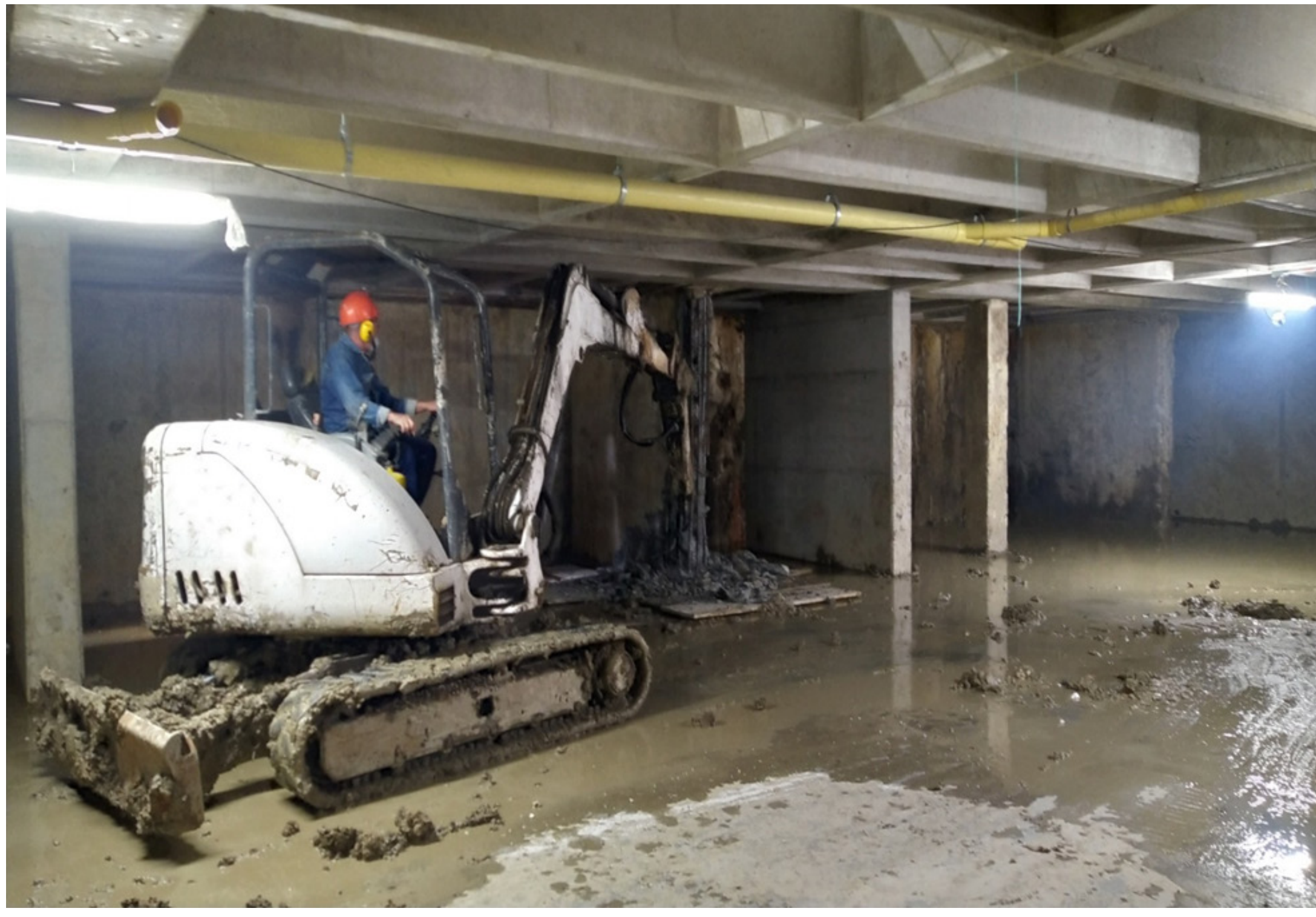
Demolición contrafuertes
