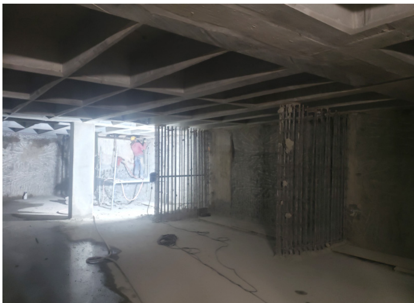
Demolición contrafuertes
