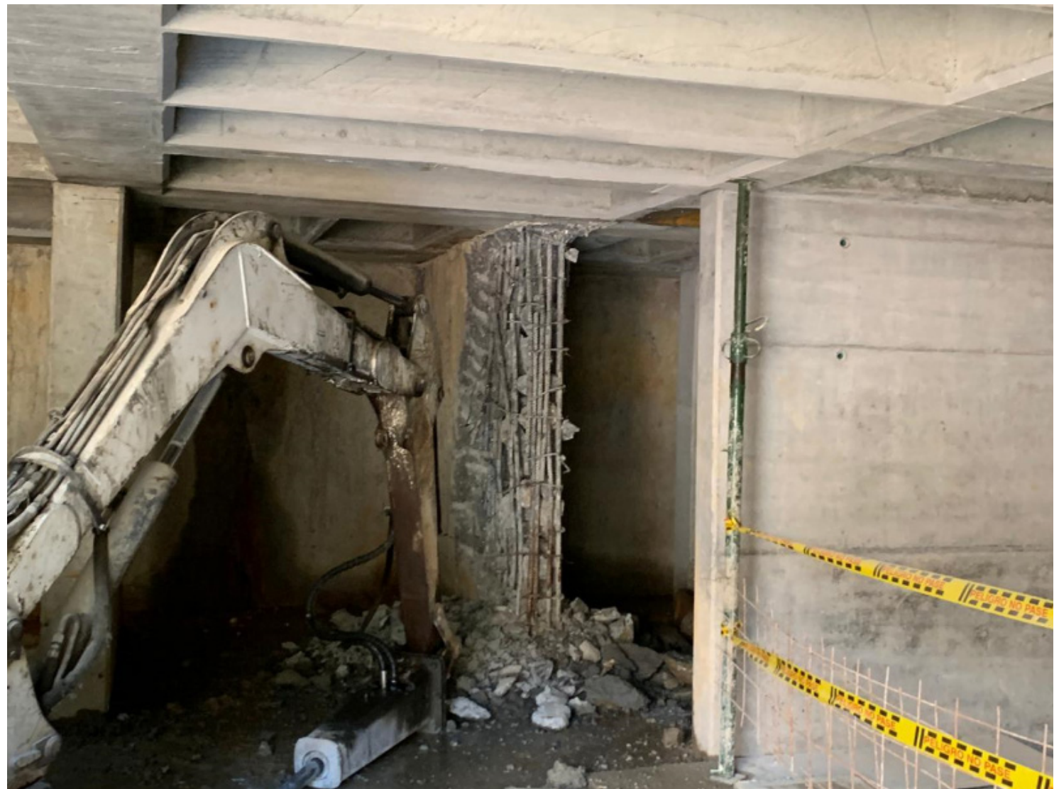
Demolición contrafuertes
